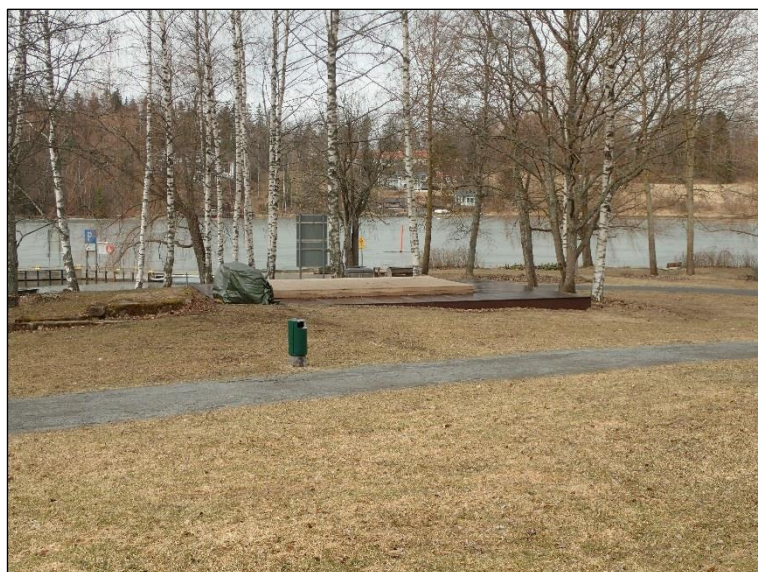
Lava ja betoniperustan pohjoisosaa, länteen
