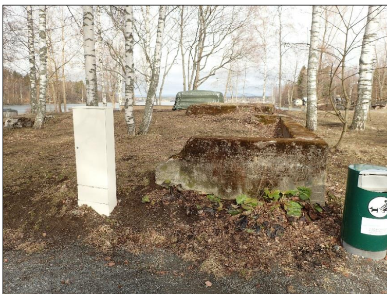
Betoniperustan kaakkoiskulma, pohjoiseen.
