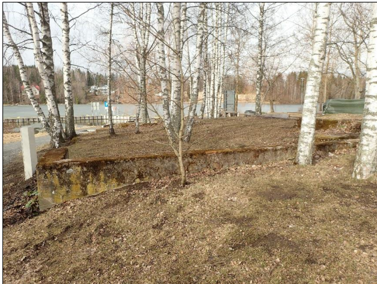
betoniperustuksen itäreunaa, länteen.
