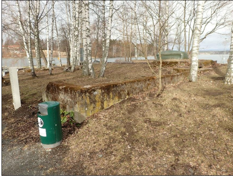
Betoniperustuksen kaakkoiskulmaa luoteeseen.
